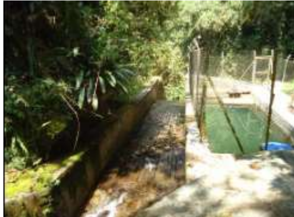
Fotografía 5-47. Captación quebrada La Fría acueducto municipio de Fredonia, Antioquia
