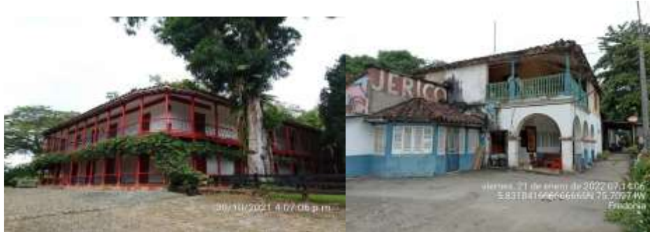
Fotografía 5-63. Hacienda Botero y Estación del Ferrocarril Jericó
