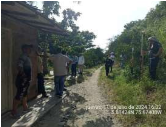
Fotografía 5-29. Ubicación mojón de eje de la línea en sector La Guajira de la vereda Puente Iglesias
