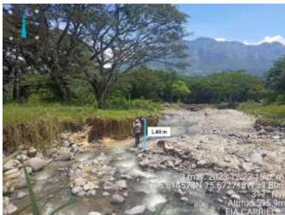
• Proceso de erosión fluvial en margen izquierda, aguas arriba del puente
