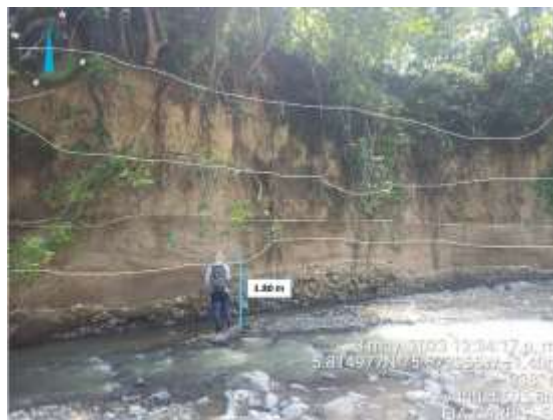
• Ladera y acumulación de sedimentos en margen derecha, aguas arriba del puente
