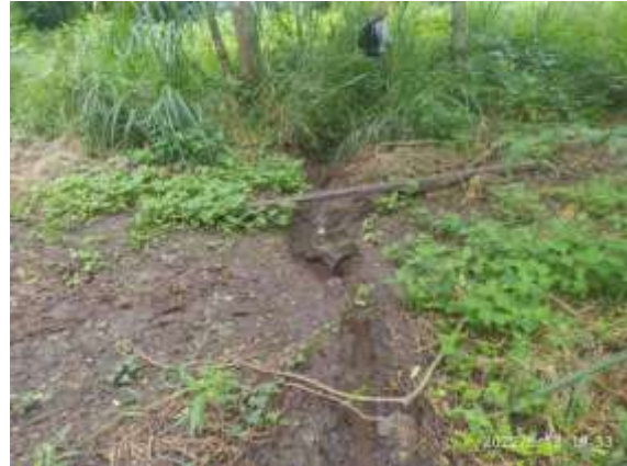
Fotografía 5-18. Acequias utilizadas para el manejo de la escorrentía en la zona de anegación (2022).
