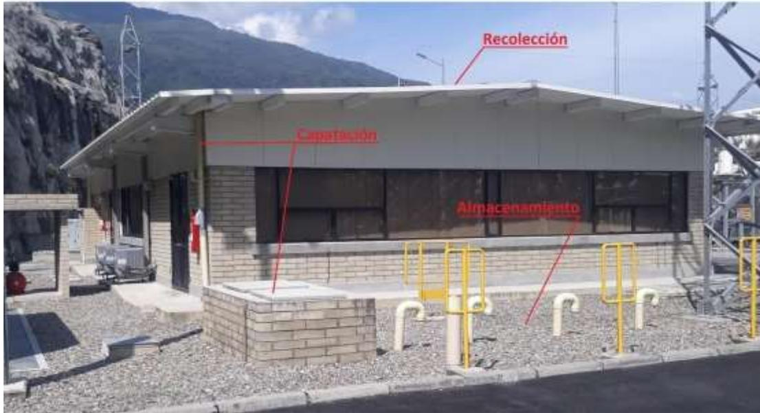
**Figura 3-18. Sistema típico de captación de agua lluvia en cubiertas – para la Subestación**
