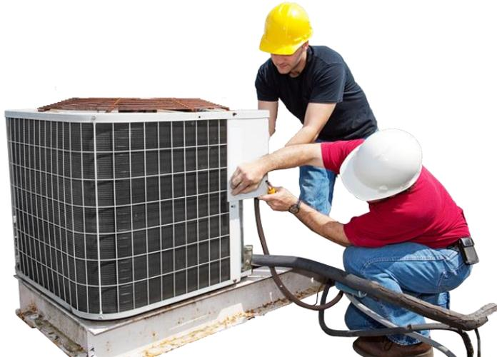
Los procesos de cargue o descargue de gases, se deben seguir las buenas prácticas para el manejo de los mismos con el fin de evitar fugas.
