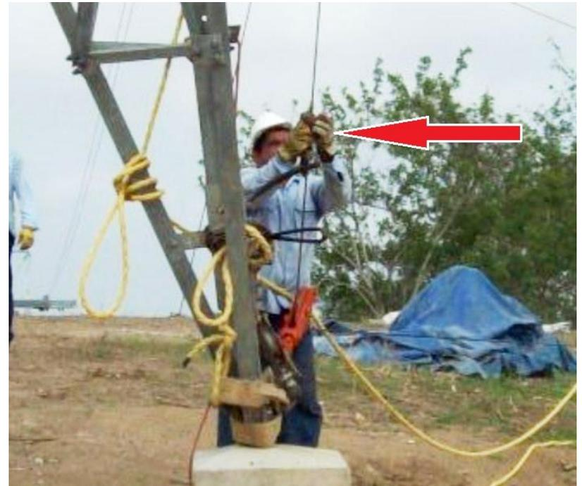
Con el malacate en esta condición original se corre el riesgo de que la cuerda de tiro se suelte o se salga del tambor, con lo cual la carga queda libre y el cable adquiere una velocidad incontrolable, lo que puede ocasionar lesiones o muerte al personal y daños en equipos y materiales
